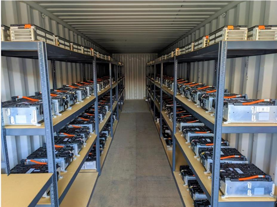
Lager mit 2 MWh geprüften Batterien
